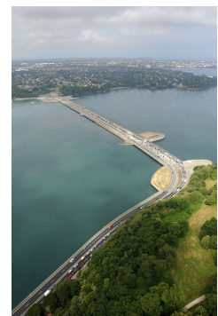
Usine marémotrice de La Rance
