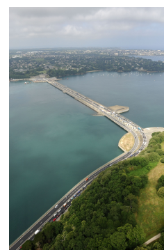
Usine marémotrice de La Rance
